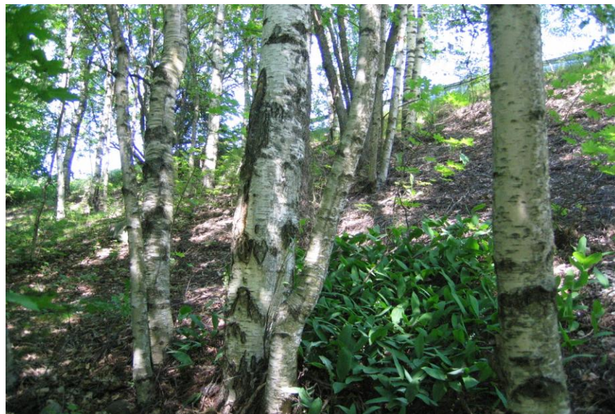
Kuva 4.9 Hintsan maapato, Raision vesilaitos. (Antti Leskelä)
