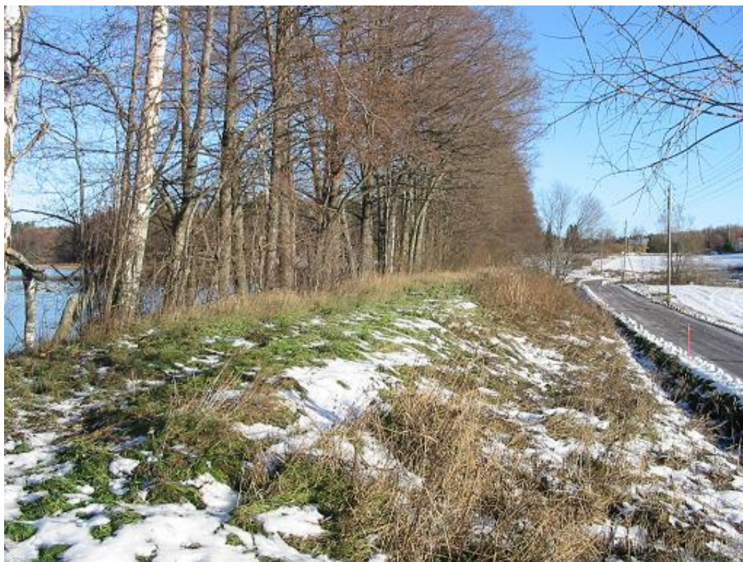
Kuva 6.24 Peltokosken voimalaitospadon vasemman puoleisen maapadon loppuosassa kasvavaa tiheää puustoa märällä luiskalla. (Mikko Sulkakoski)
