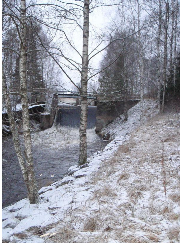
Kuva 6.22 Myllykylänkosken padon alapuolella olevassa kivetyksessä kasvavaa puustoa.
