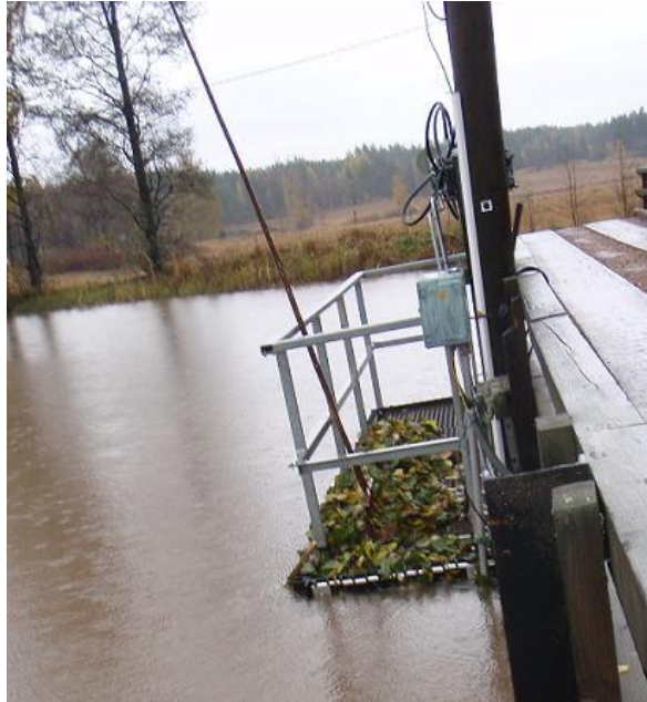
Kuva 6.3 Kantturakosken välppään kerääntyneet lehdet.
