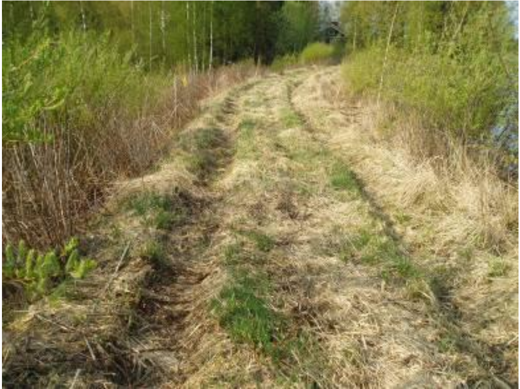
Kuva 6.19 Torran tulvapenkereen harjalla syvät traktorin jäljet 2007. (Kari Virtanen)
