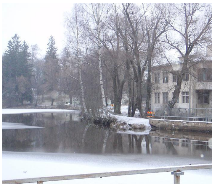
Kuva 6.23 Kellokosken voimalaitospadon maapato-osuudella kasvavaa suurehkoa puustoa.
