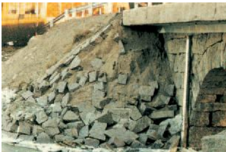
Kuva 6.21 Esimerkki sortuneesta keilaverhouksesta. (Rämetsä & Huura 2004)
