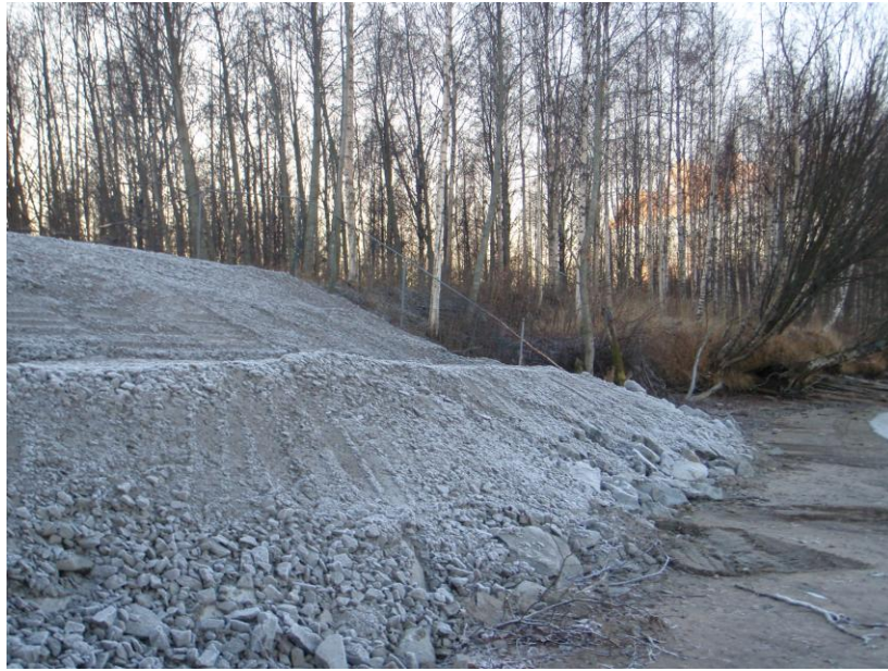
Kuva 6.9 Korjattua ja korjaamatonta tulvapengertä Lukkarinrannassa.
