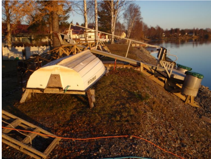
Kuva 6.7 Tulvapenkereen päälle rakennettu porrastasanne ja laituri sekä vene talvisäilytyksessä penkereen päällä.
