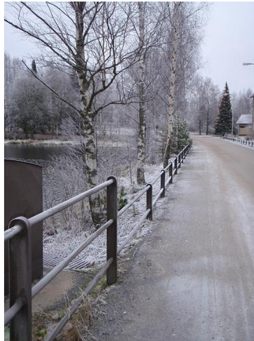
Kuva 6.15 Hartolankosken voimalaitospadon vasemmanpuoleisessa maapadossa kasvavaa puustoa.
