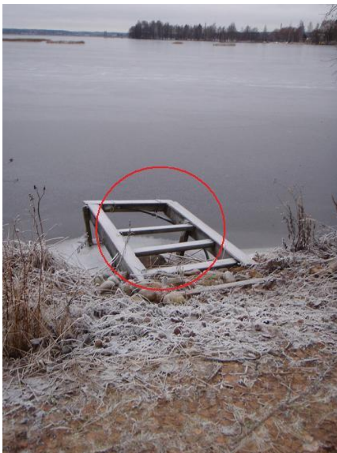
Kuva 6.17 Roismalan tulvapenkereen lävitse luvattomasti kaivettu putki.
