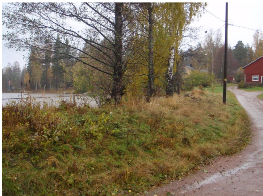
Kuva 7.4 Kantturakosken maapato 19.10.2009, kuiva luiska.
