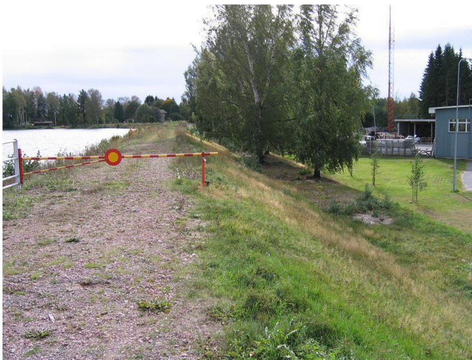
Kuva 4.3 Harjavallan voimalaitoksen maapadolla kasvavaa kasvillisuutta. (Mikko Sulkakoski)
