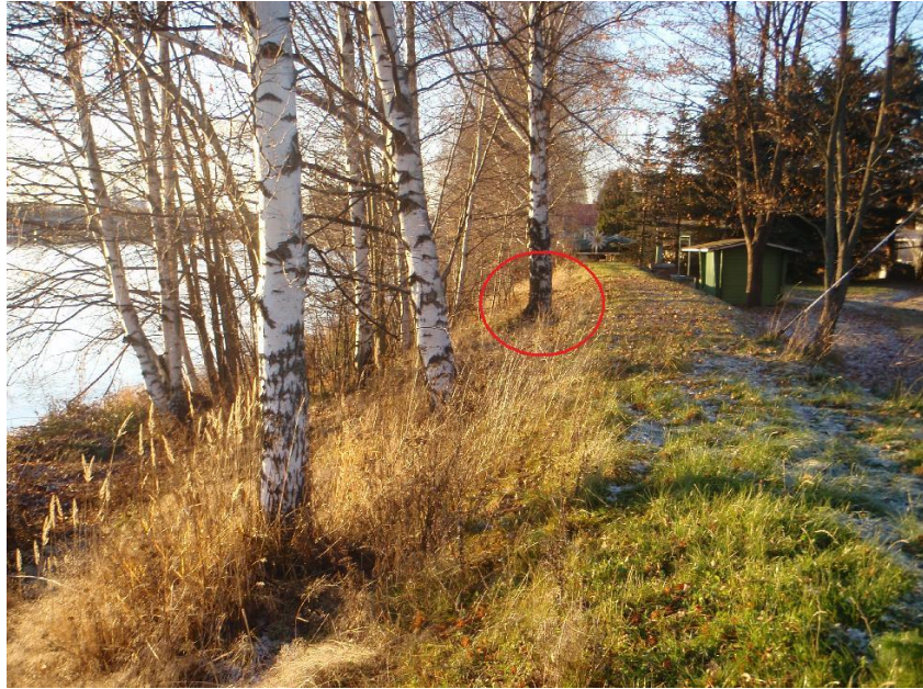
Kuva 6.4 Koivuja tulvapenkereen märällä luiskalla Isojoenrannassa.
