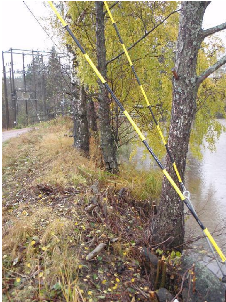
Kuva 6.2 Kantturakosken maapadon määrällä luiskalla kasvavaa puustoa.
