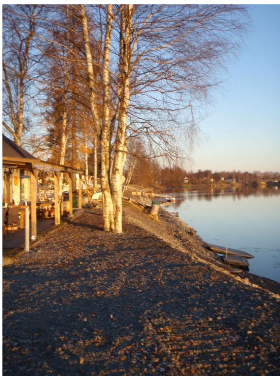
Kuva 6.6 Koivuja tulvapenkereen harjalla Isojoenrannassa, Lukkarinsillan vierustal- la. Maapato on rakennettu talon pilarien alla olevasta pystysuuntaisesta betonimuu- rista joen puolelle päin.
